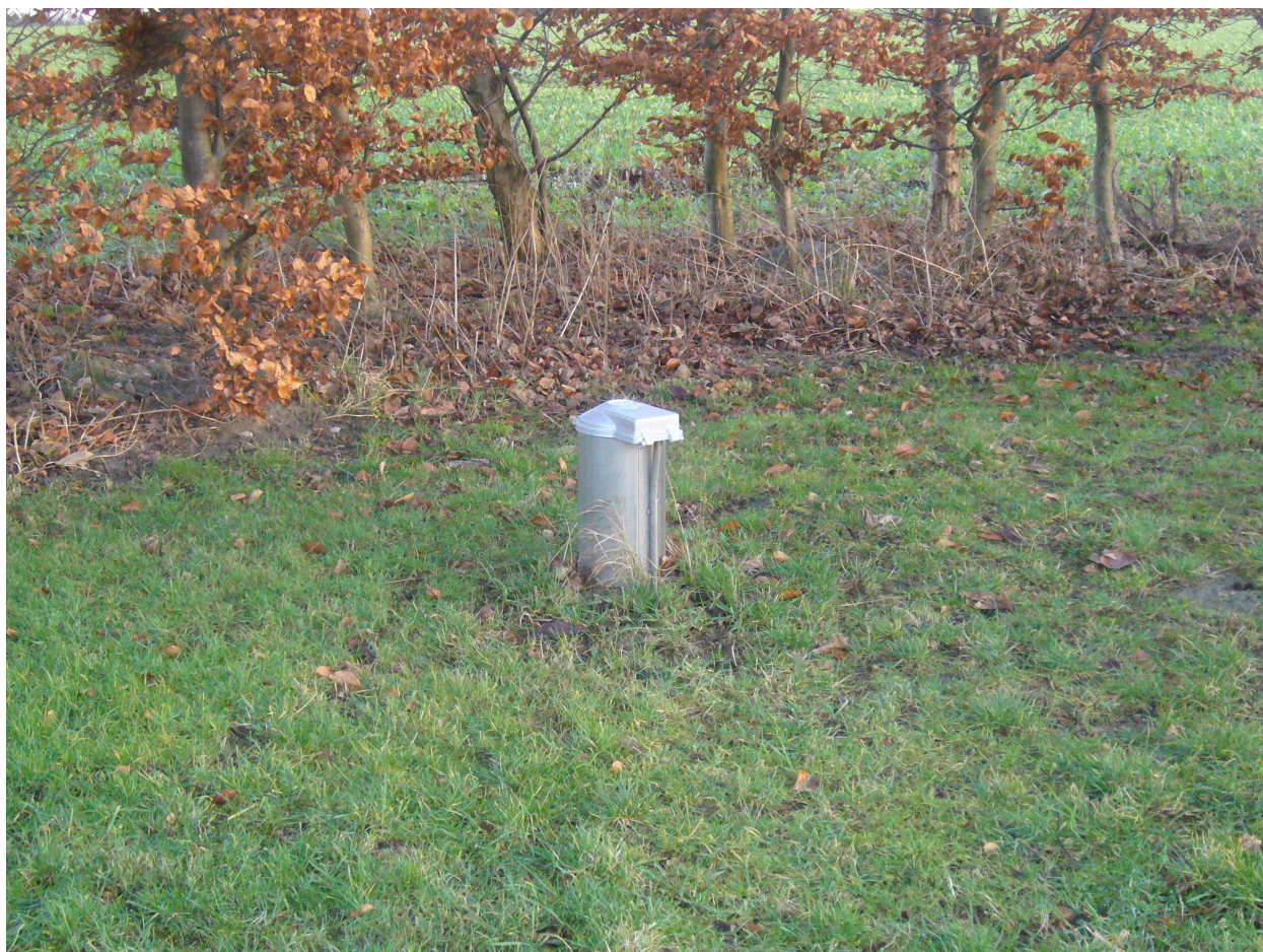
Nyetableret ikke-almment vandforsyningsanlæg.
